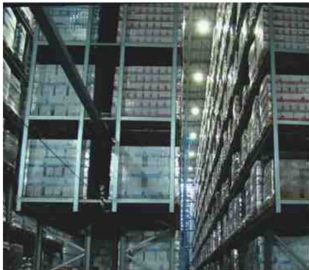
Im Regallager wird nur dort Licht benötigt, wo Stapler oder Mitarbeiter sich bewegen.
