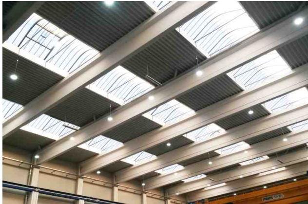
Bei Tagelicht regeln die Leuchten automatisch zurück, bei Sonne bis zum Abschalten.
